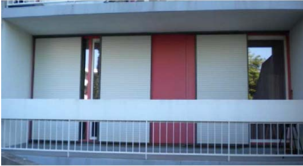
Parois extérieures légères donnant sur les loggias
