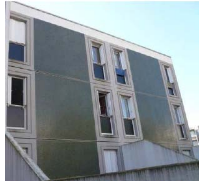
Façade béton double peau isolée
